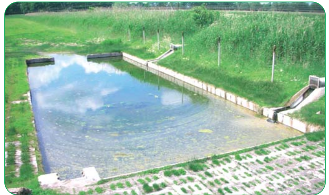
Abb. 7.4: Instandsetzung: Grundhafter Ausbau einer Fischgrube
