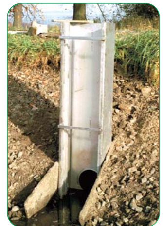
Abb. 7.5: Instandsetzung: Einbau eines modernen Edelstahlständers
